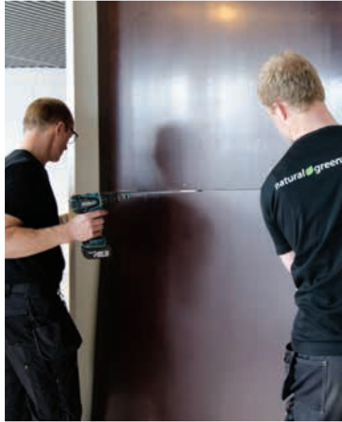
Aufbau der Rückwand mit Wasserfesten Platten.
