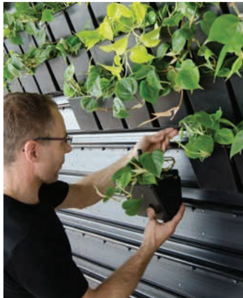
Die Natural Greenwalls® Pflanztopfe werden in den Schienen eingeklickt.
